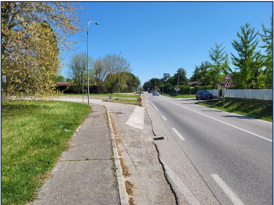
Ripresa n. 4: intersezione via Padova – via del Lavoro
