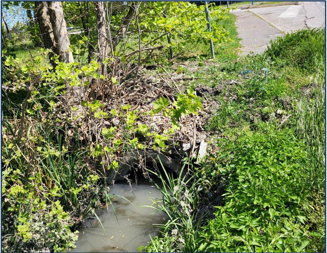
Ripresa n. 3: inizio collettore interrato intersezione via Padova – via del Lavoro
